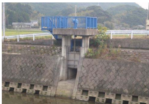
写真 4.1.1-1 引上げ式ゲート樋門
